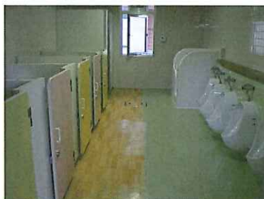
← 改修された 北園舎トイレ
